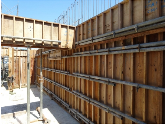
現在の型枠工事
