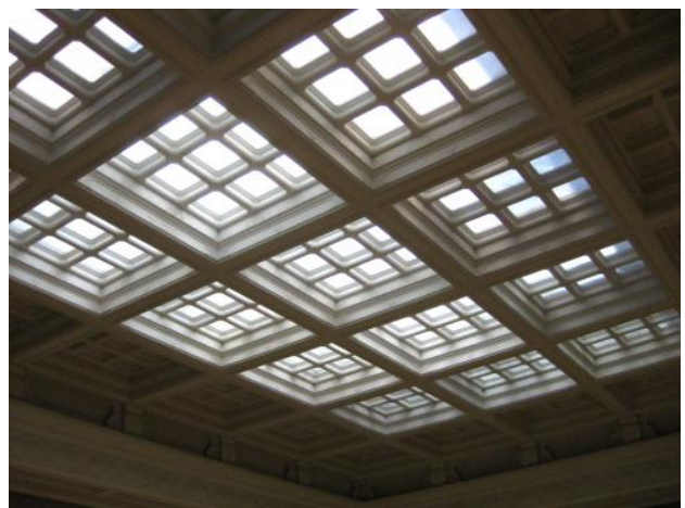
階段室の格天井
