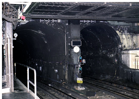
テムズ川の地下鉄トンネル
