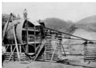
構外でのシールドの仮組み立て
