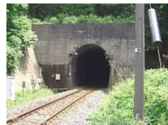
折渡トンネル
